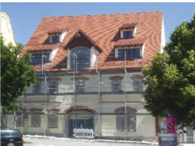
So sehen die Fassade und das Dach nach der Renovierung aus.
